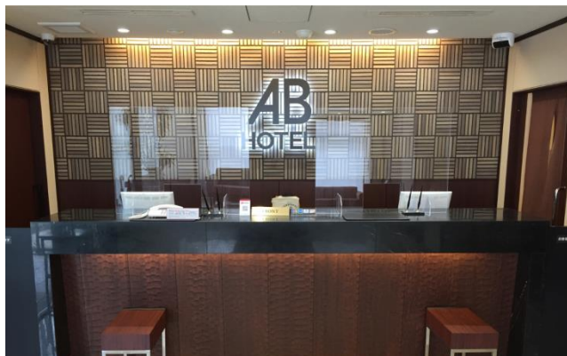
飛散防止シートの設置
